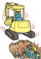
バックしてきたバックホウにより土砂が崩れて、土砂に埋まった
