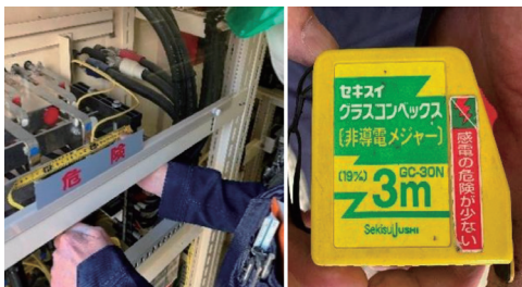
写真-4 絶縁スケール使用 (CB 内部)
