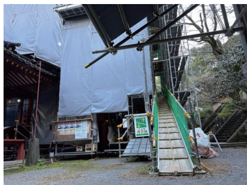
写真-2 仮設木製スロープ入口
