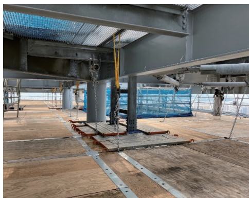
写真-6 クイックデッキ上作業場
