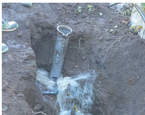
写真－2 不明管損傷
