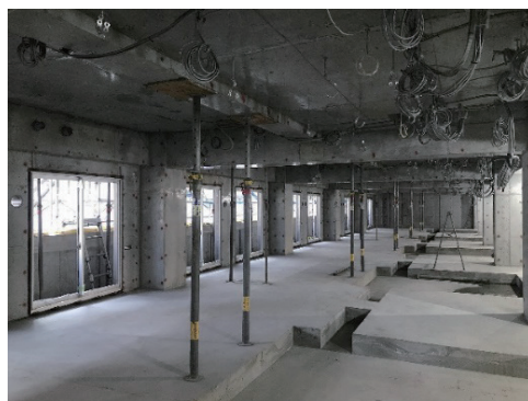
写真-9 クイックサポート配置状況
