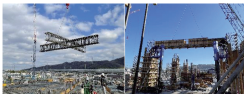
写真-7 鉄筋・型枠地組状況
