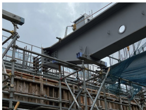
写真-7 アンカーボルト部納まり
