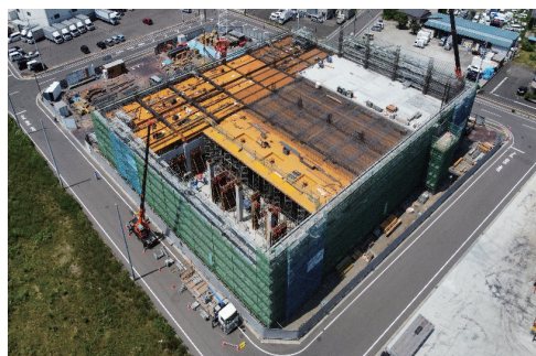
写真-9 スラブ型枠施工状況
