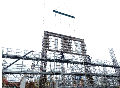
写真-7 大判パネル施工状況
