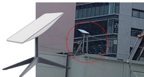
写真-3 スターリンク本体と設置状況
