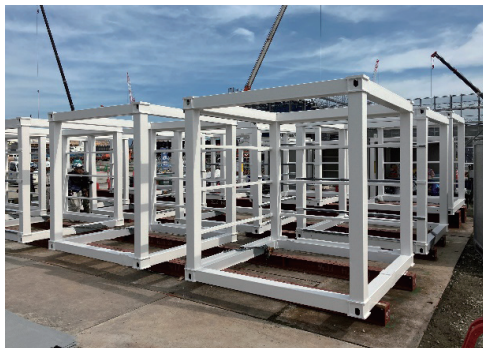
写真-11 セルのユニット施工状況
