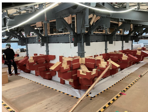
写真-3 軒下組物施工写真
