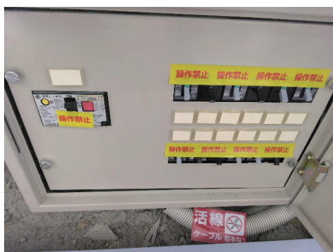
写真-4 分電盤 操作禁止表示の実施
