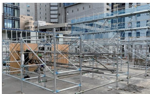
写真-2 柱鉄筋の組立ヤード
