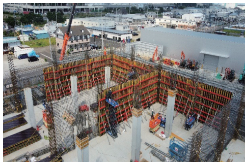
写真-6 システム型枠施工状況
