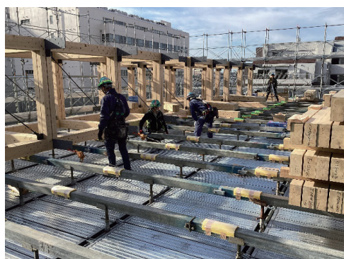
写真－1 下弦材レベルの測定状況
