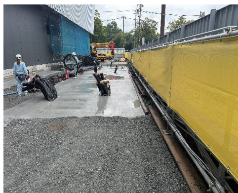
図-9 配管保護兼作業通路
