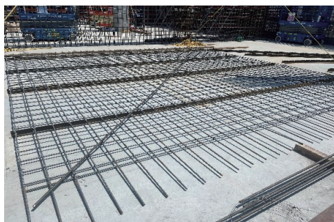
写真-4 壁鉄筋先組状況
