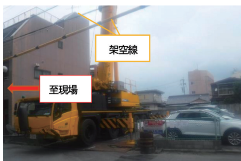
写真-7 70tTC 解体時の 120t トラッククレーン
