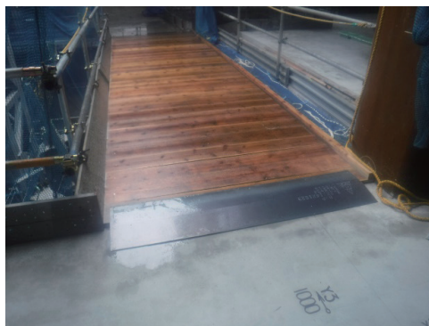
写真-4 後施工開口を利用した搬入構台
