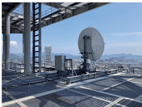
写真-2 アンテナデッキ 25 階(地上 100m付近)
