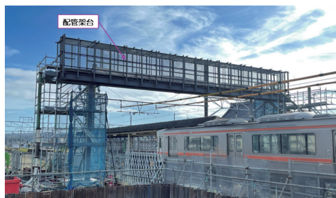
写真-5 線路上空の配管架台
