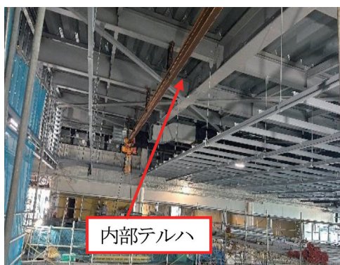
写真-2 テルハクレーン設置状況
