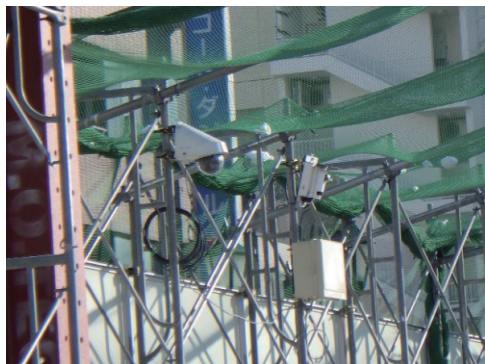
写真－7 ウェブカメラ設置状況
