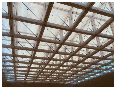
写真－10 木造トラス梁の出来形
