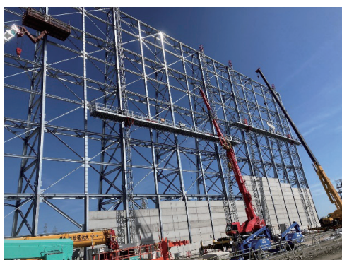
写真-4 リフトクライマー設置状況
