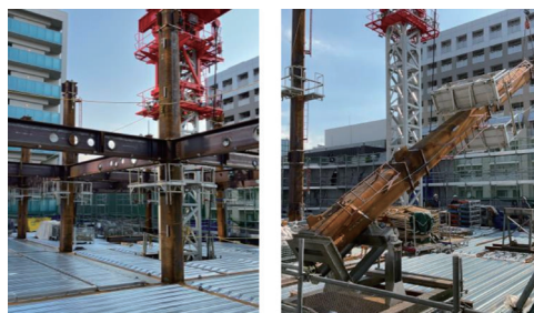
写真-14 外部足場内での鉄骨組立作業状況
