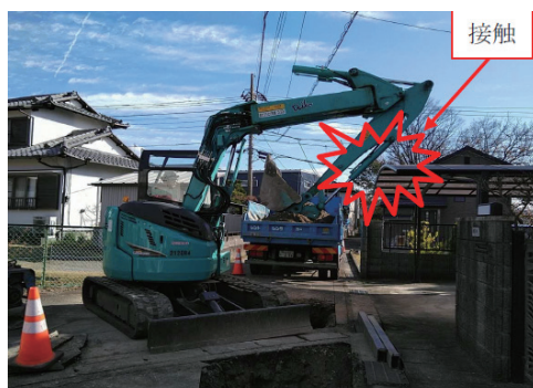
写真－3 架空線切断・近隣住宅への接触
