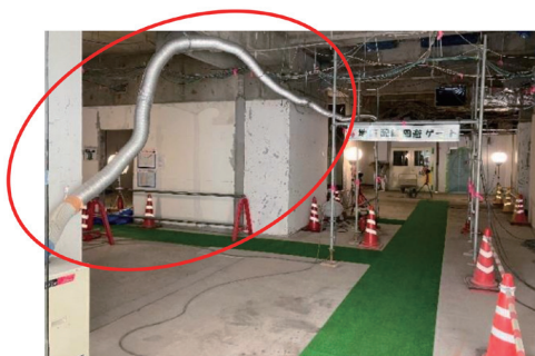
写真-8 作業場所までのダクティング状況
