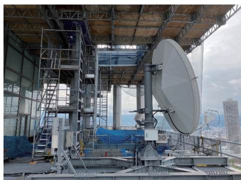
写真-4 クイックデッキ設置完了
