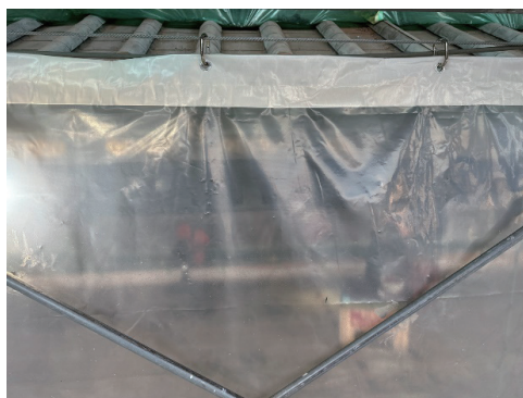
写真-6 現場製作した透明シート養生
