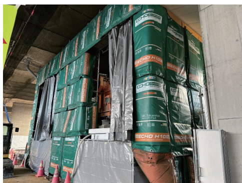
写真-7 プラント周囲の防音足場設置
