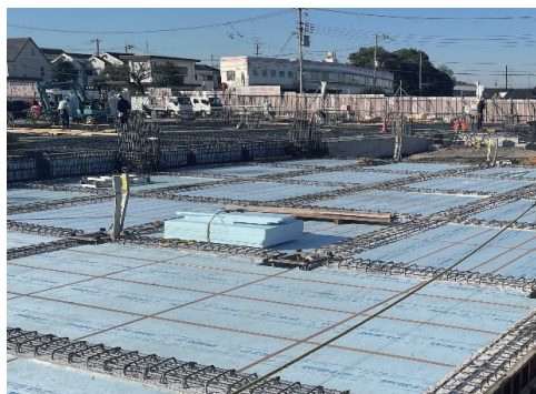
写真-6 断熱型枠施工状況
