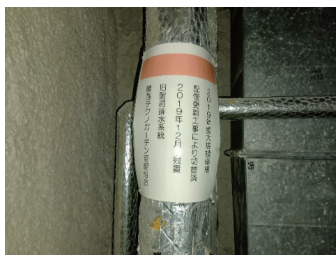
写真-7 残置配管看板取付
