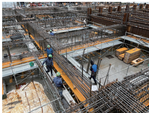
写真-5 梁配筋用足場設置状況
