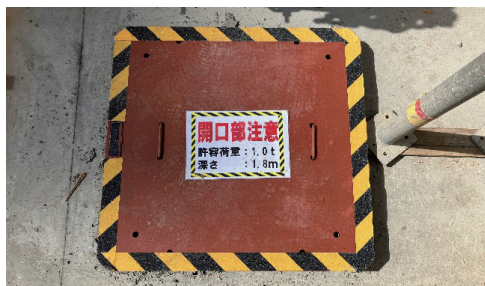
写真-9 床開口部鋼製板設置状況
