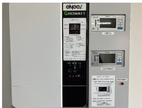
写真-4 ソーラーバッテリーハウス 内部制御盤
