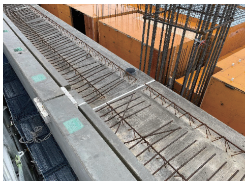
写真-5 ハーフプレキャスト据付状況
