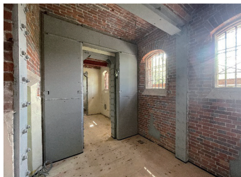
写真-12 界壁開口部補強鉄骨工事完了
