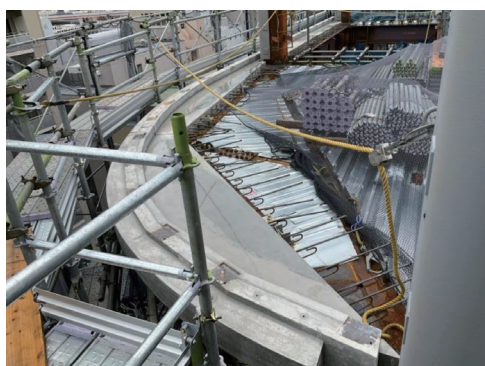
写真-28 はねだしスラブ PC 化
