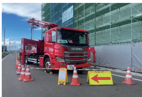
写真-10 道路からのコンクリート打設
