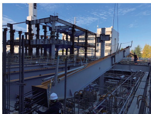
写真-6 鉄骨建方状況
