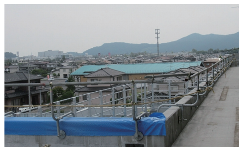
写真-4 安全手摺設置状況
