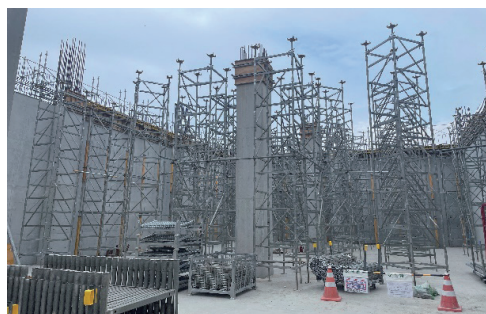
写真-8 STシステム支柱組立状況
