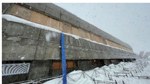
写真-18 ベニアにより開口部養生
