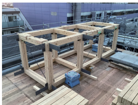
写真-4 ユニット同士をブロック化 (ブロック化した木トラス)
