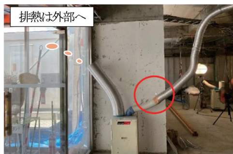
写真-7 スポットクーラーのダクティング
