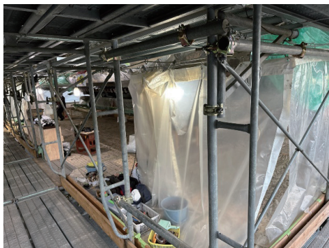
写真-5 現場製作した透明シート養生
