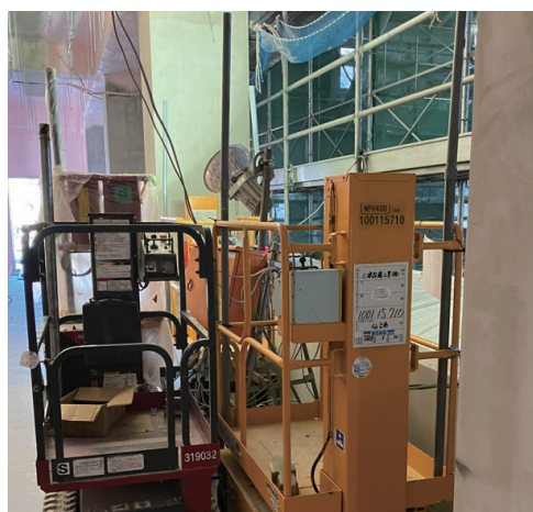
写真-3 挟まれ防止用単管設置状況
