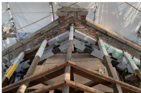
写真-3 妻面補強鉄骨と小屋組み補修
