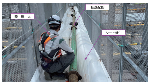
写真-6 配管架台下部の養生、監視人配置
