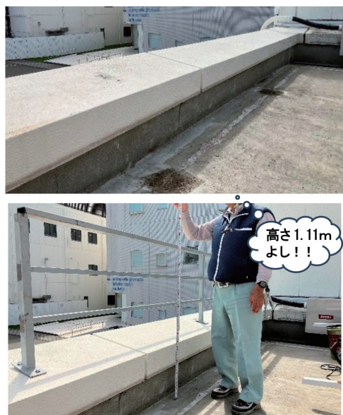
写真-5 本設手摺として先行設置
