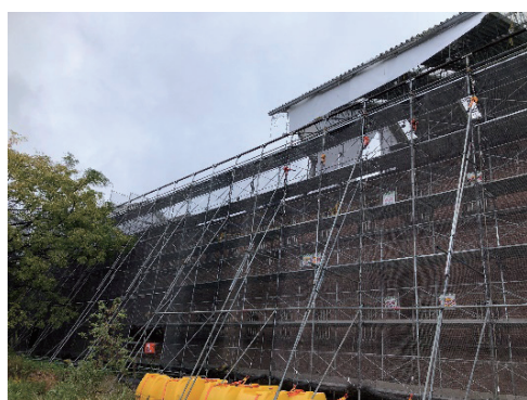
写真-8 外部側控え斜材（やらず）
