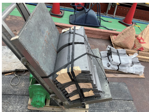
写真-6 瓦ウインチ揚重物固定写真
