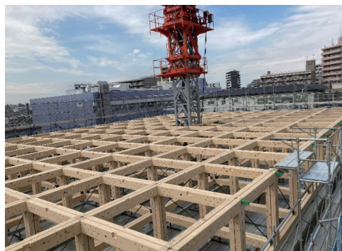
写真－8 トラス建込完了
