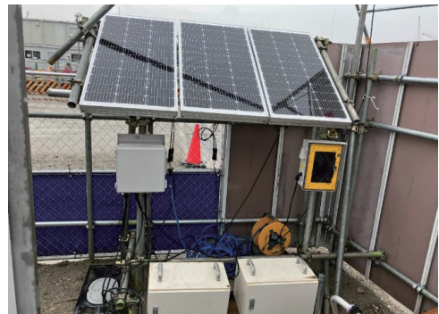
写真-13 ソーラーとバッテリー設備
