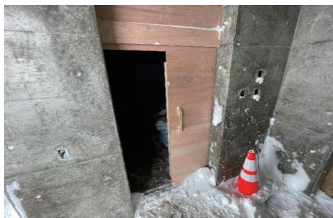
写真-19 ベニアによる引き戸を設置
