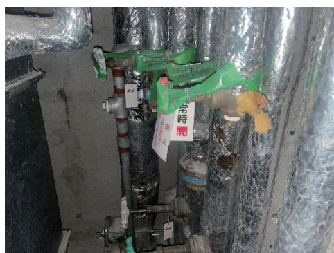
写真-6 バルブ閉止 テープ固定
