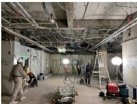
写真-3 蛍光ピンクリボンによる活線明示
