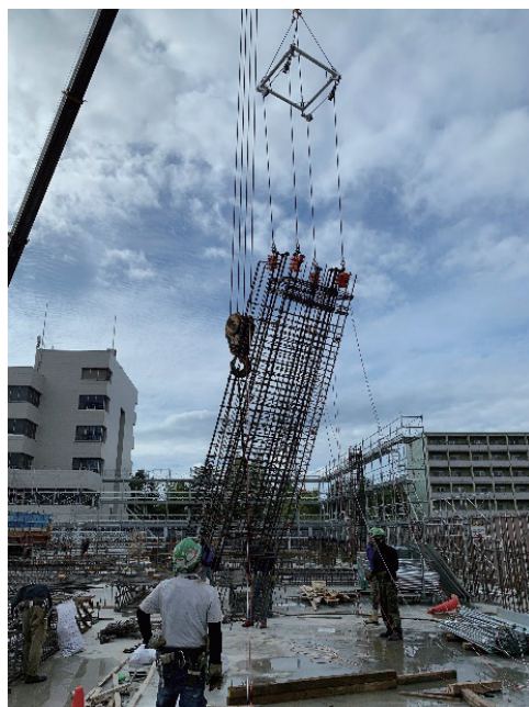
写真-4 柱鉄筋建て起こし状況
