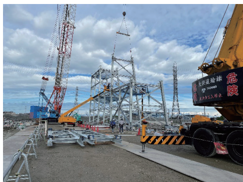
写真-2 鉄骨建方状況（2節）
