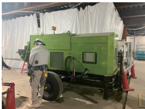
写真-27 電動ポンプ設置状況 (地上スラブ 1000m3 打設)
