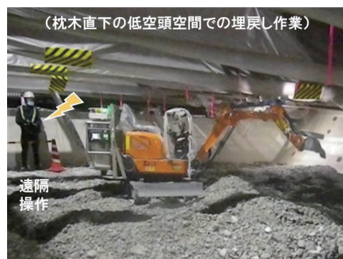
写真-3 サロゲート ® を用いた作業状況
