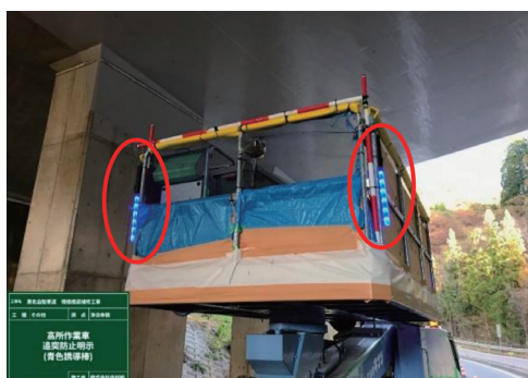
写真－7 青色誘導棒設置（高所作業車デッキ）
