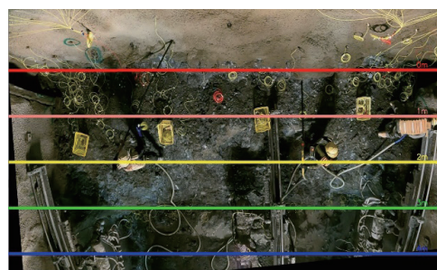
写真-6 遠隔装填機による路盤上での装薬状況 (天端カメラ)
