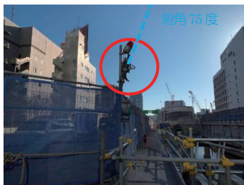
写真-4 レーザーバリアの設置状況
