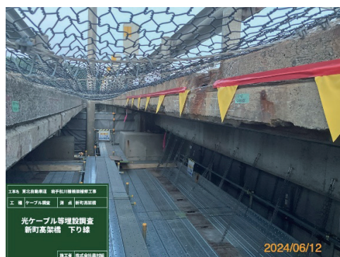
写真－10 埋設ケーブル位置明示
