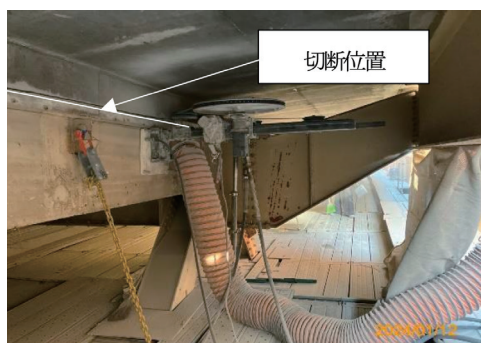
写真-7 水平ワイヤーソー施工状況
