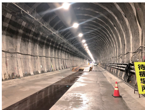
写真－1 坑内照明設備
