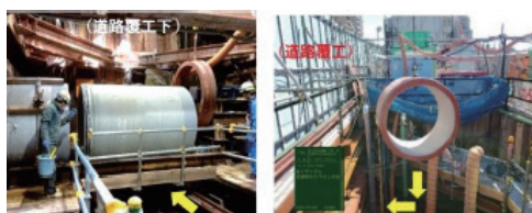
写真-4 トラバースによる管渠の横移動状況
