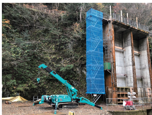
写真-5 チェーン式吊階段
