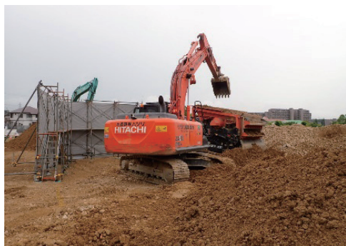
写真-7 ふるい分け作業状況
