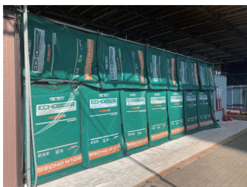
写真-7 エコーバリア設置状況
