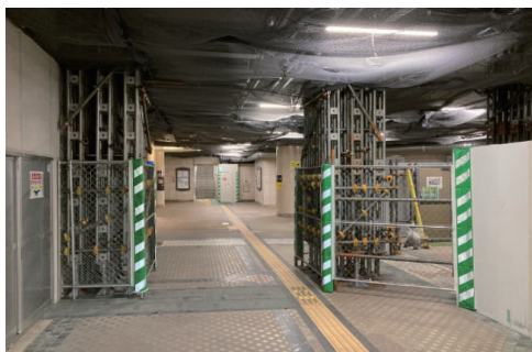
写真-2 支保工設置状況
