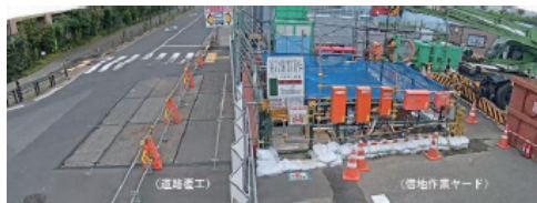
写真-3 No.7 立坑覆工設置、道路開放状況
