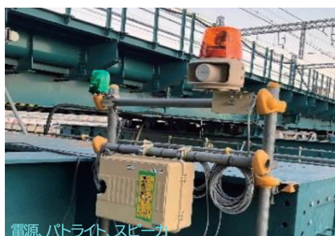
写真－３ レーザーバリア設置警報装置
