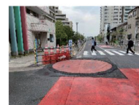
写真-6 立坑掘削機搬出、覆工板設置状況
