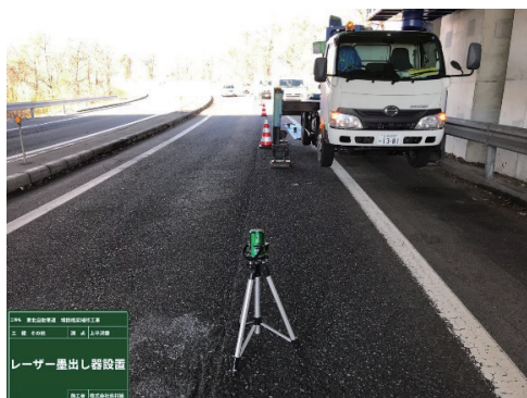
写真－6 レーザー墨出し器設置（規制帯内）
