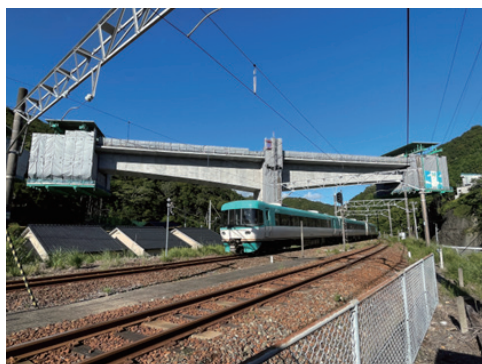
写真-1 線路上空の架設状況
