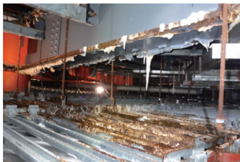
写真－1 天井内腐食状況
