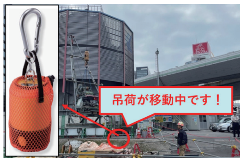
写真-5 玉掛け警報装置の使用状況
