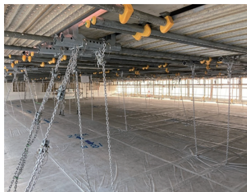
写真-4 クイックパネライト設置状況
