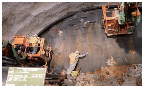
写真-1 人力による装薬作業全景
