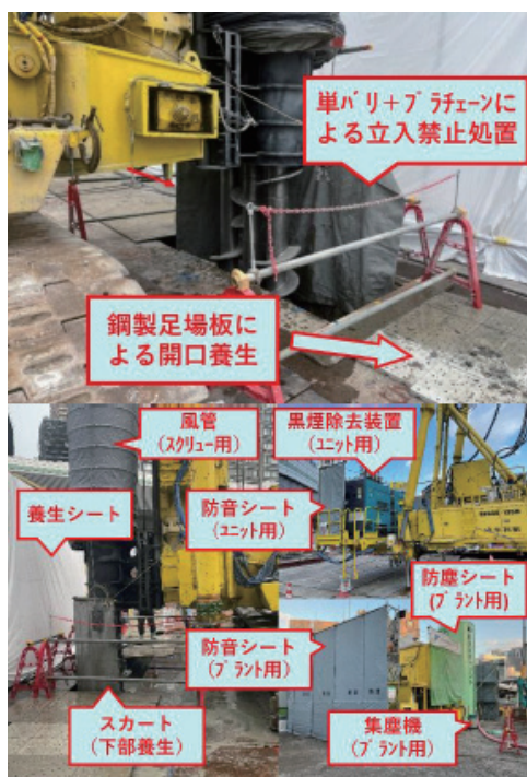
写真-6 SMW施工時の安全環境対策
