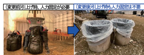
写真-5 大型土のう作成機の変更
