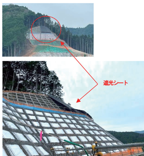
写真-6 遮光シートの設置状況
