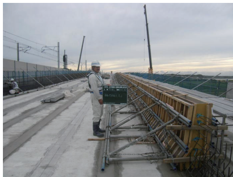
写真-5 壁高欄場所打ちコンクリート型枠組立状況
