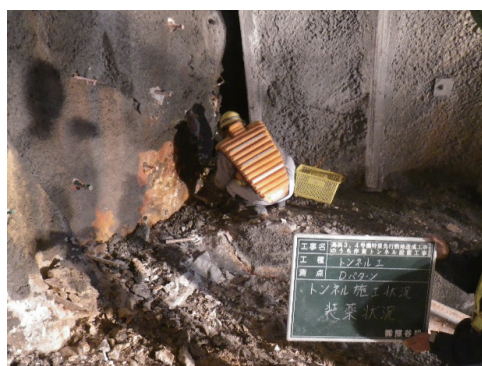
写真-2 人力による装薬作業状況
