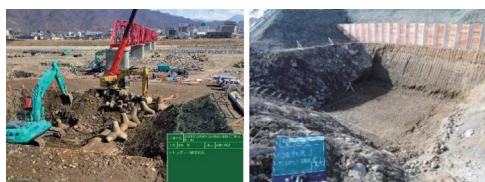
写真-3 A2 橋台異形ブロック撤去及び完了状況
