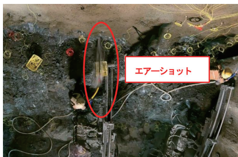
写真-8 装填機のエアショット機能による発破孔清掃状況(天端カメラ)
