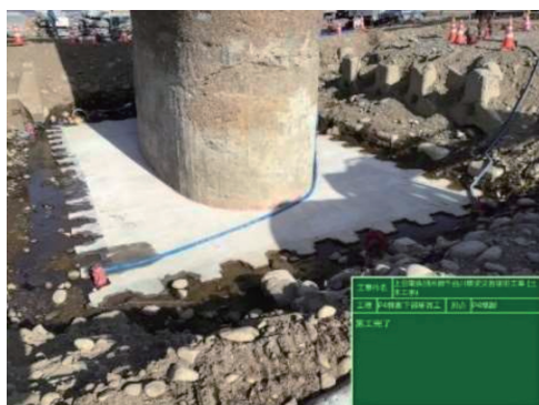
写真-7 P4 橋脚周りの補強状況（本補強）
