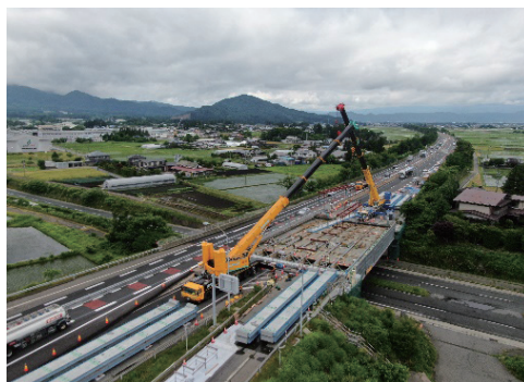
写真-10 新床版架設状況（400t クレーン）
