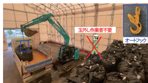
写真-6 オートフックを用いた取卸し状況
