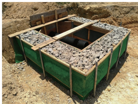
写真-13 割栗石による吐口スクリーン
