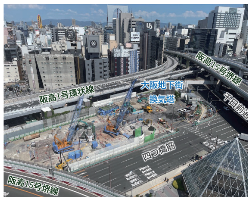
写真-1 地中障害物撤去状況
