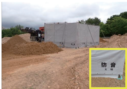
写真-6 防音シート設置状況
