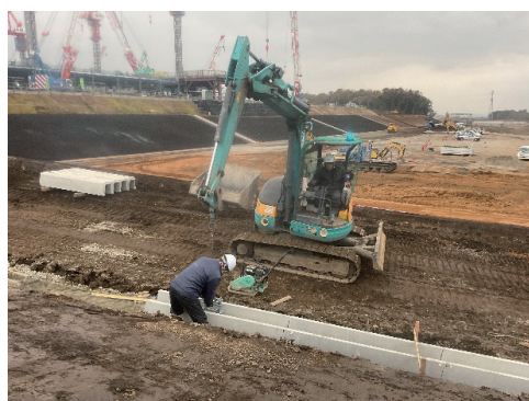
写真-4 重機停止明示用青色ランプの設置
