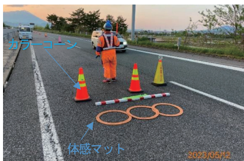
写真-13 出入口誘導員の物理的防護
