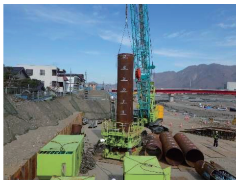
写真-4 A2 橋台復旧状況（基礎杭打設）
