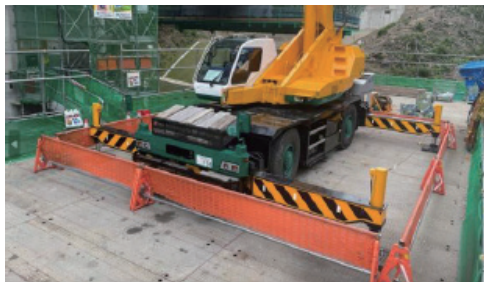
写真-8 旋回体周辺の立入禁止措置
