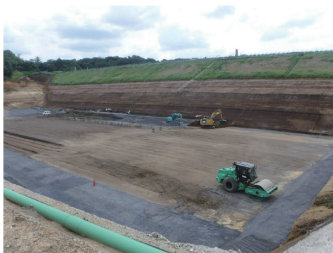
写真-3 ICT 振動ローラー転圧状況
