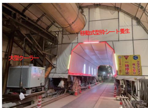
写真-5 移動式型枠養生状5
