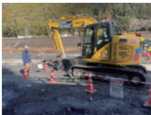
写真-3 重機搭載磁界型検知器使用状況
