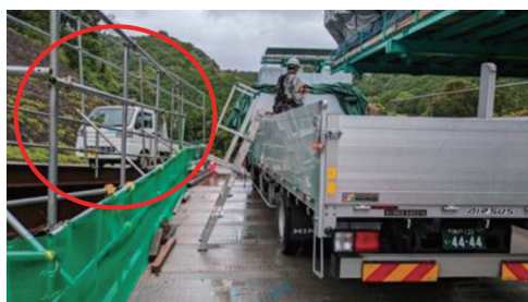
写真-12 トラック荷台からの墜落防止
