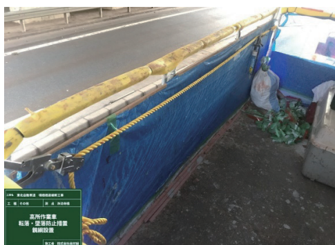
写真－8 親綱設置（高所作業車デッキ内）
