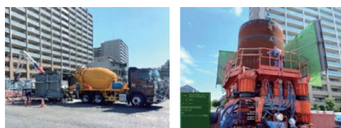
写真-10 ポンプ車、全周回転掘削機 防音対策
