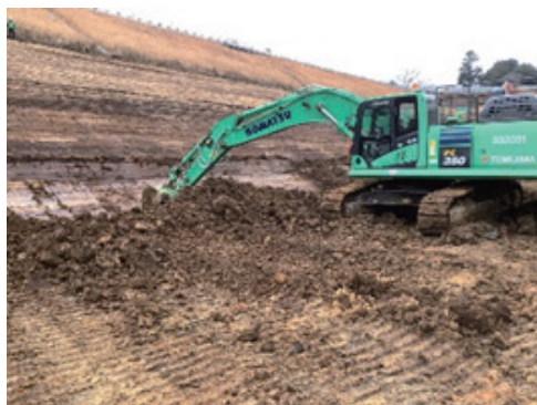
写真-1 ICT バックホウによる法面整形状況
