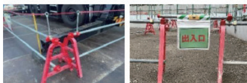
写真-4 隙間のない立入禁止処置の徹底
