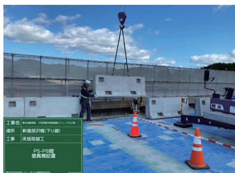
写真-6 プレキャスト壁高欄設置状況
