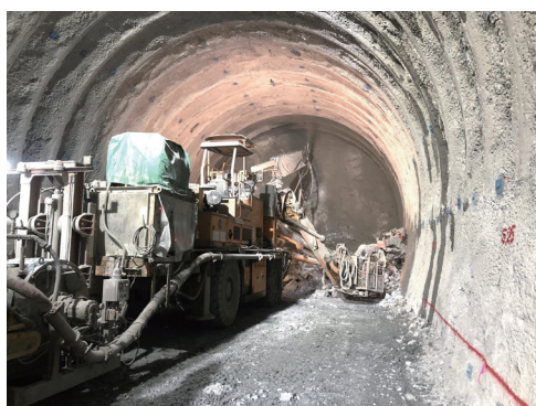
写真-3 吹付コンクリート状況
