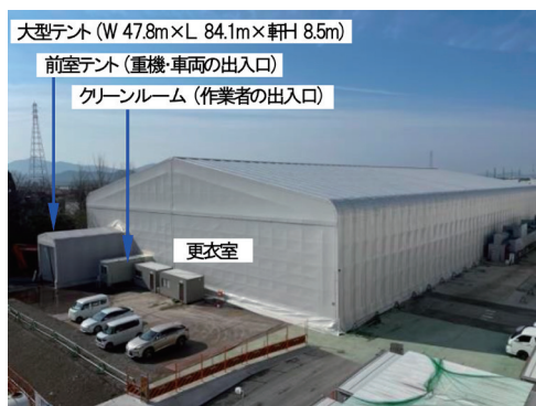
写真-1 飛散防止用テント(大型テント)
