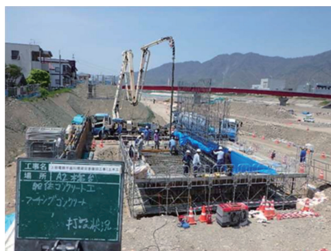
写真-5 A2 橋台復旧状況（コンクリート打設）
