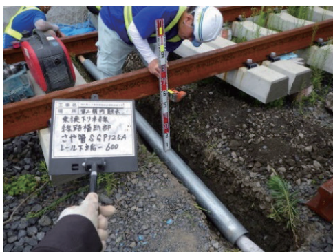
写真2 配管横断部施工状況
