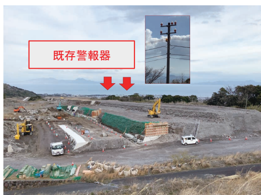
写真-2 施工現場周辺の様子①
