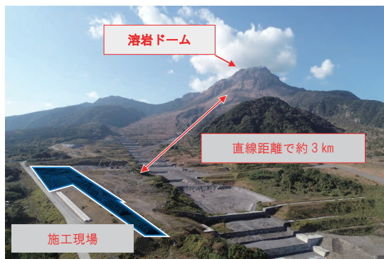
写真-1 溶岩ドームと施工位置の関係
