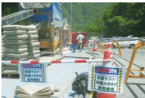
写真-5 作業エリアの明示
