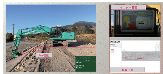
写真－６ 転圧バケット+ICT
