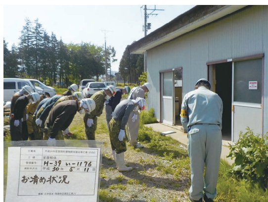
写真－3 解体工事着手前の安全お清め実施状況
