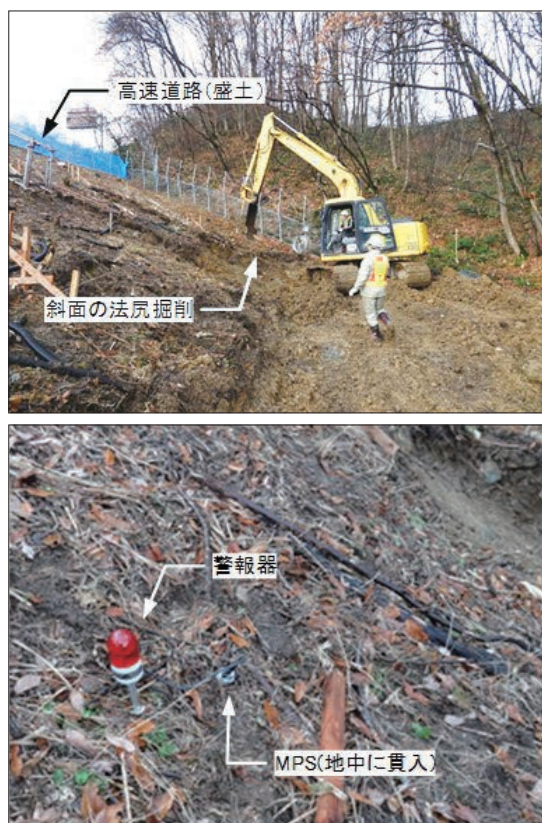
図-5 斜面の法尻掘削 (左) と掘削部の上方に設置した MPS 装置 (右)
