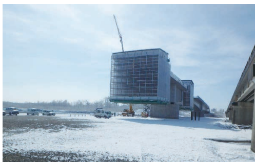
写真－3 河川敷の使用状況（資材を堆積しない）
