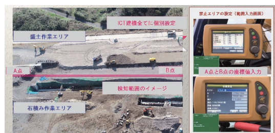
写真－５ ICT 建機を利用した作業分離措置
