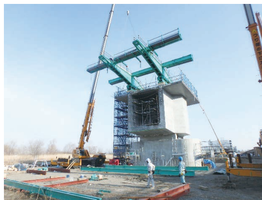
写真-2 移動作業車組立状況
