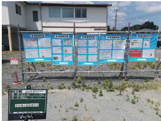
写真－１ 安全掲示板設置状況
