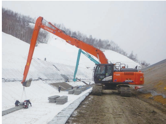
写真－3 ロングブームバックホウによる護岸ブロック設置作業
