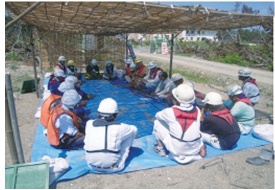
写真－１ 海岸防潮堤工事現場で安全教育
