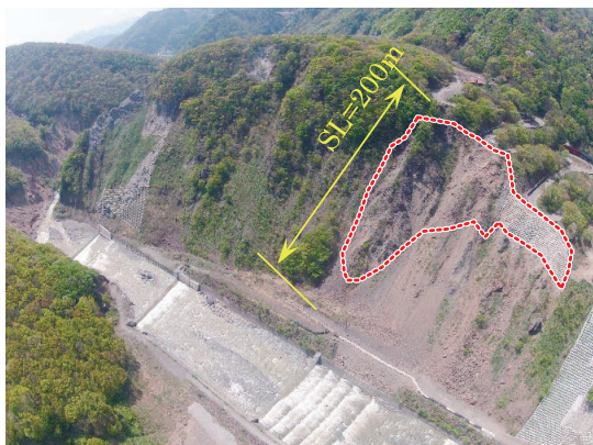
写真-1 葛葉下流斜面 平成27年5月時点 ※点線内 弊社施工範囲
