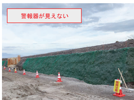
写真-3 施工現場周辺の様子②
