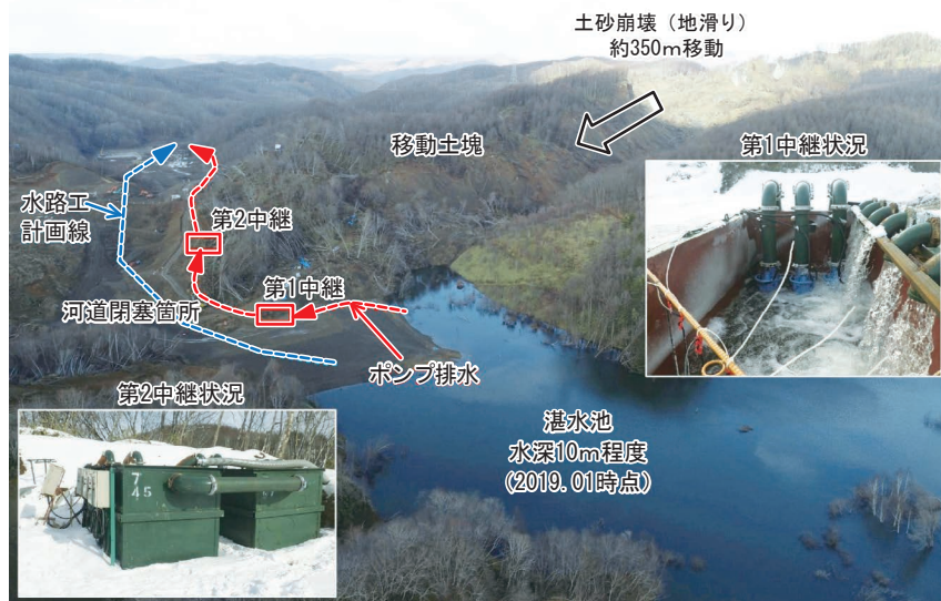
写真－2 ポンプ排水状況
