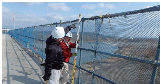
写真-11 床端部の仮設柵
