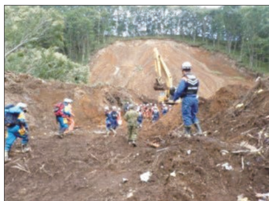
a) 崩壊した斜面の下に堆積した土砂
