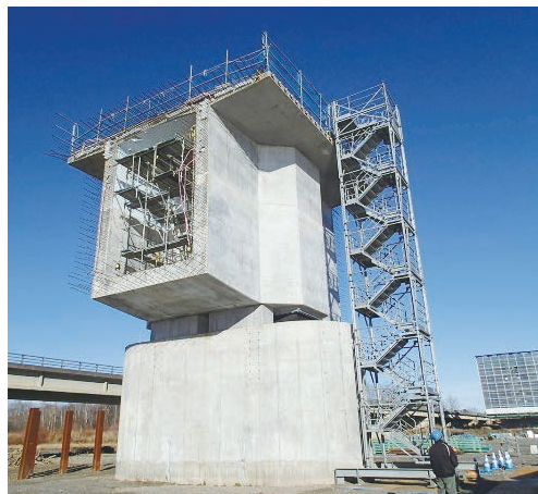
写真－4 強力バンドによる昇降設備
