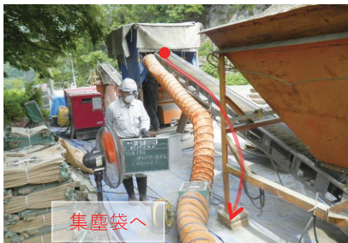
写真-6 送風機による粉じん回収
