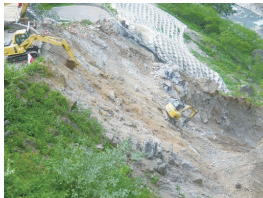
写真-2 無人化施工機械での法面掘削
