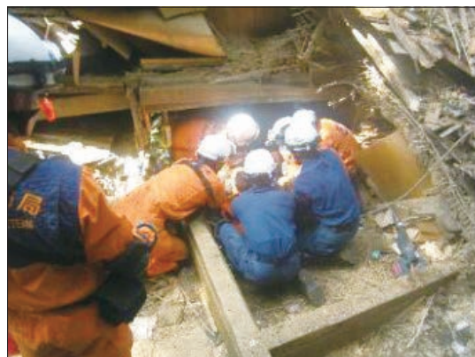
写真－2 豪雨による斜面崩壊後に地面を掘削しての救出活動（平成30年台風21号） *5
