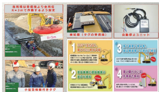
写真－４ 作業者接近検知システム+自動停止
