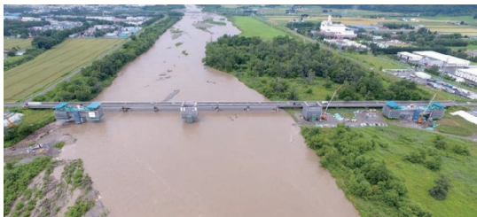
写真－６ 増水中の施工状況
