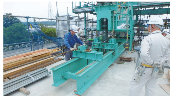
写真－10 移動作業車移動状況
