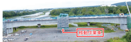
写真－９ 中央閉合施工状況
