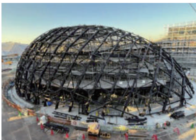
写真-1 外殻鉄骨全景
