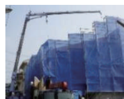
水平ジブクレーン上棟工法
