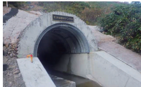
写真-1 取水施設と排水トンネル
