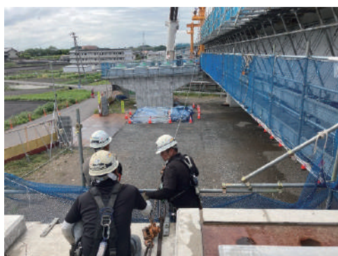
写真-11 軸力計設置状況
