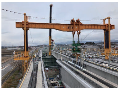
写真-3 クレーン・リフター相吊り架設
