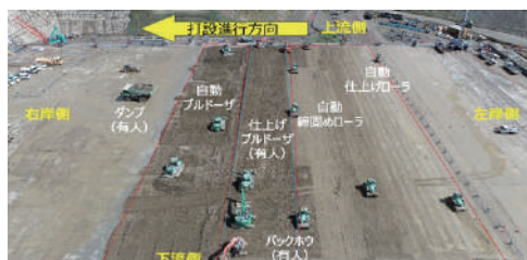
写真-1 自動化重機による CSG 打設状況
