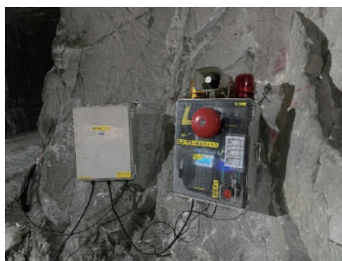
写真-7 通信設備設置状況(19階層切羽近傍)
