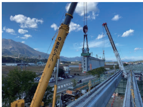
写真-2 クレーン相吊り架設
