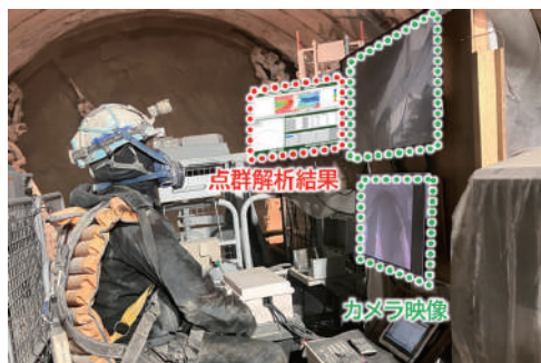
図-5 遠隔吹付け状況
