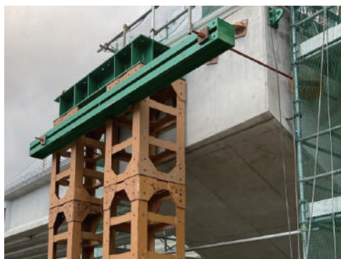
写真-8 ゲビンデ鋼棒による固定
