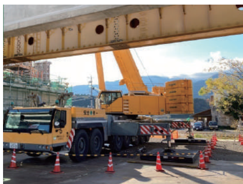
写真-5 アウトリガー養生状況
