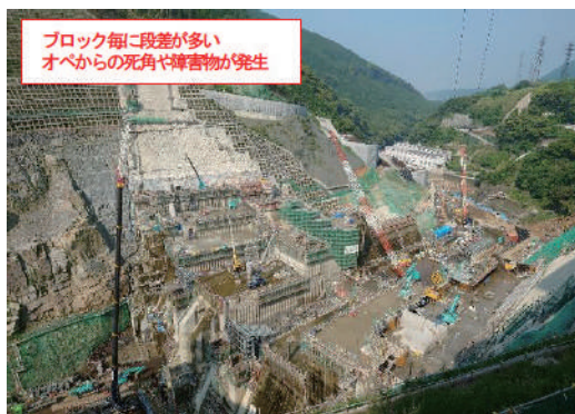
写真-2 堤体コンクリート打ち上がり状況
