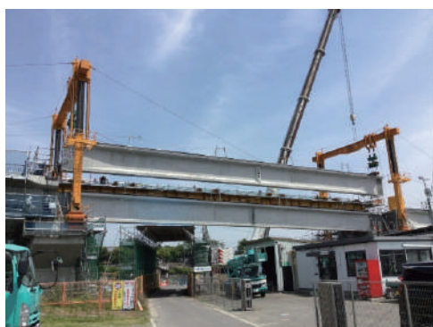
写真-4 門型油圧リフター相吊り架設
