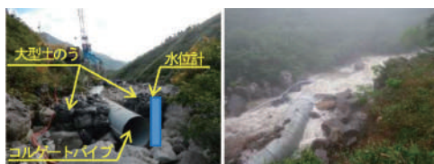
写真-2 仮締切被災前・後
