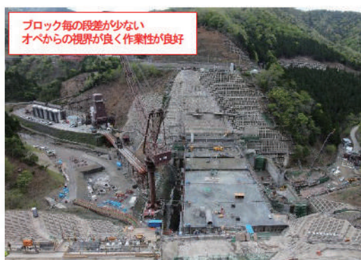
写真-2 堤体コンクリート打ち上がり状況
