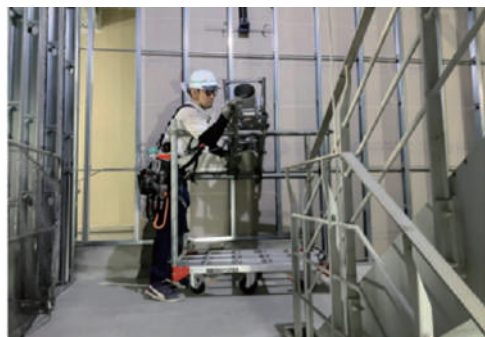
写真-8 サーキュレーター設置状況
