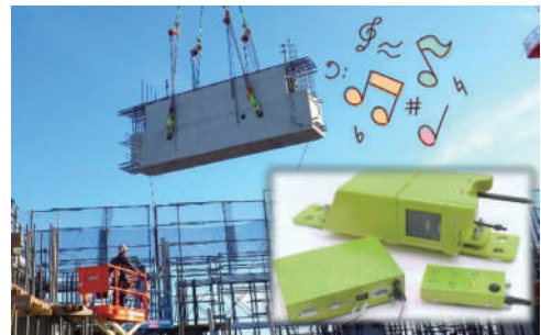
写真-3 吊荷下部の警報システム
