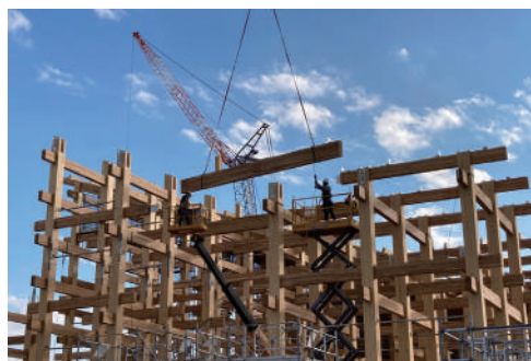
写真-1 高所作業車作業状況
