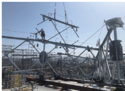
図-8 発進構台上での鉄骨建方状況
