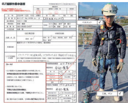
写真-14 端部作業申請と落下防止ヒモ
