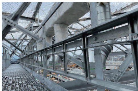
図-13 構台上での配線ラック工事写真
