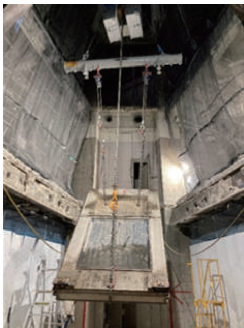
写真－10 吊荷反転装置
