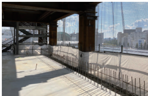
写真-3 コンクリート打設時養生状況
