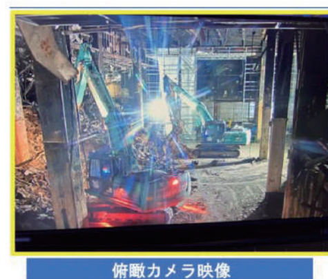
写真-9 俯瞰カメラ映像及び操縦モニター
