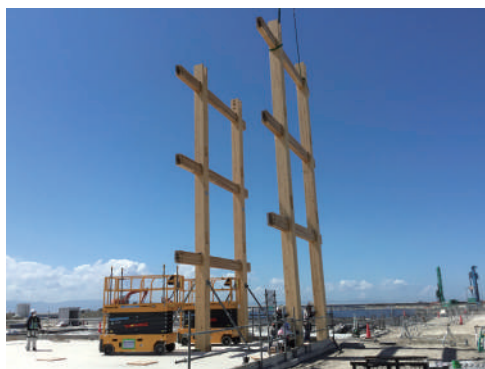
写真-4 平面ユニット建方状況
