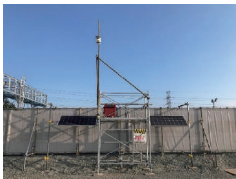
写真－17 太陽光発電を利用したWEBカメラ設置状況
