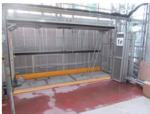
写真-13 仮設 EV のバリアフリー化
