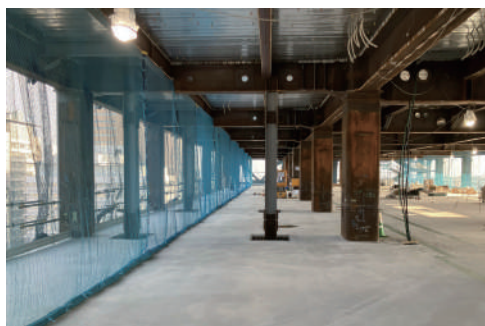
写真-4 垂直ネット設置状況
