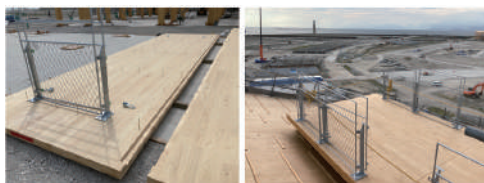
写真-10 先行手摺設置状況
