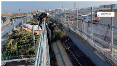
写真-13 端部仮設手摺がある作業状況
