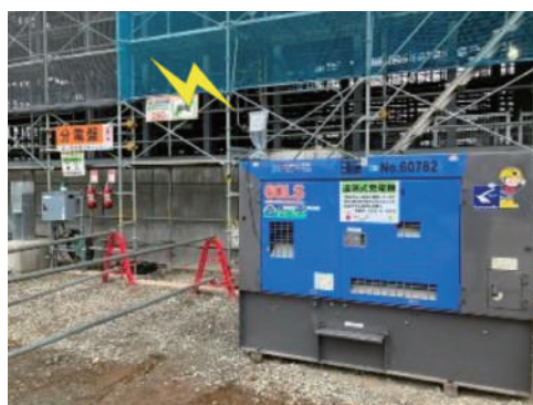
写真－16 発電機遠隔操作システム設置状況 上：工事事務所操作スイッチ・送信機 下：現場発電機
