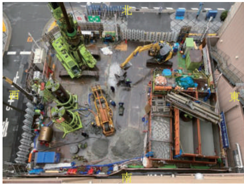
写真－１ 着工当初（場所打ち杭施工時）
