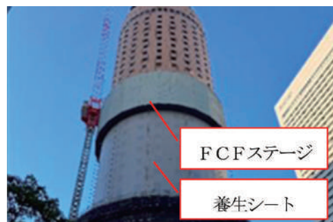
写真-6 外部養生シート設置状況
