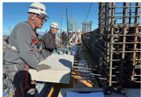
写真-3 サイト PCa の設置 (鷹工 1 業種のみ作業)
