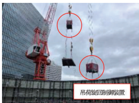
写真-9 吊荷旋回制御装置使用状況
