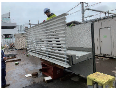
写真-7 手摺先行取付状況
