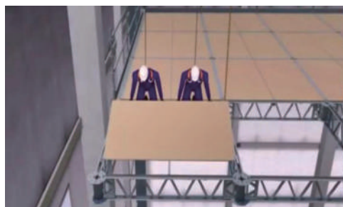
図-4 クイックデッキ組立状況イメージ
