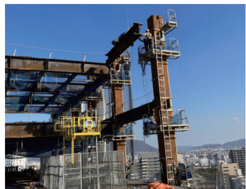
写真-2 コラムステージに先行ネット設置
