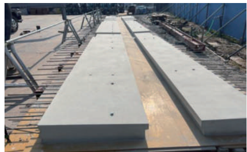
写真-2 振動しない地上でのコンクリート打設
