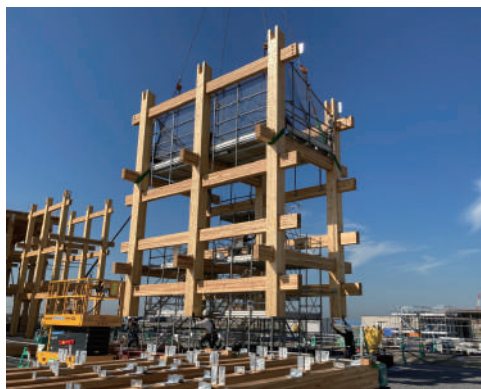
写真-7 立体ユニット施工状況
