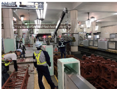
写真-4 現場での軌道車搬入状況
