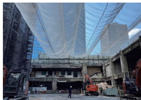
写真-7 上部養生シート張り状況
