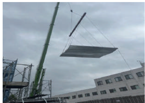
写真-6 地組した鉄筋トラス付デッキ施工状況
