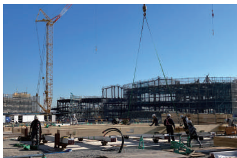
写真-3 平面ユニット地組状況
