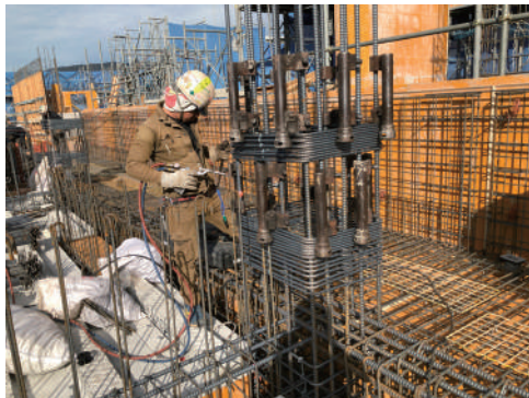
写真-4 在来工法での柱配筋工事
