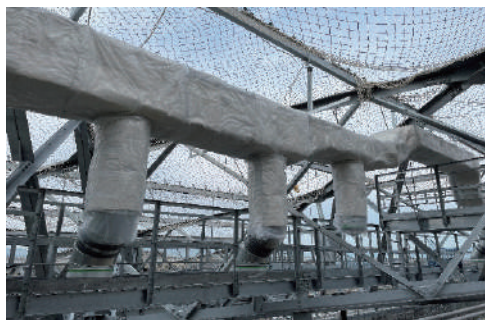
図-12 構台上でのダクト・保温工事写真
