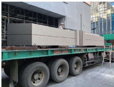
写真-5 外装塗装済み PCa 部材搬入状況
