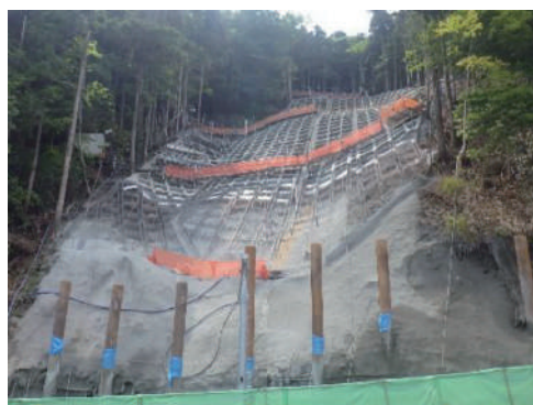
写真-8 法面補強状況
