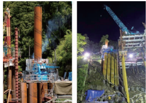
写真-7 ジャイロプレス工法施工状況
