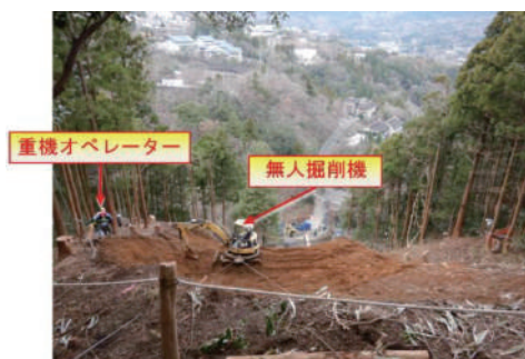
写真-3 無人化重機施工
