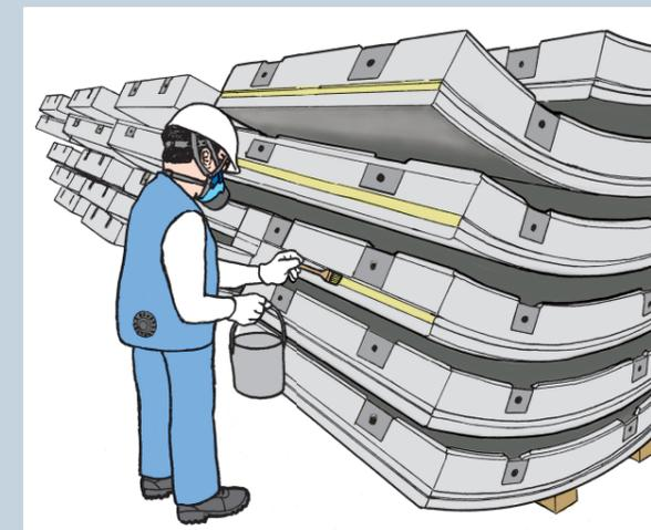
シールド工事 セグメントシール貼付け有機溶剤取扱い作業（2025年3月版）
