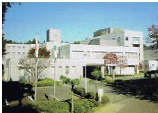
建設業安全衛生教育センターの外観
