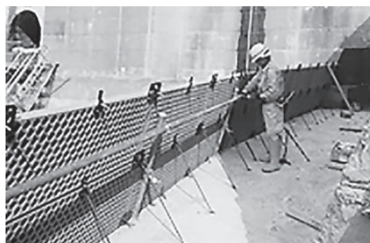
残存型枠組立て時の手摺の設置方法改善 (令和4年度受賞作品より)
