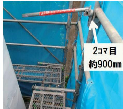
図2-18 段差のある作業床の端部にストッパーを取り付けた例
