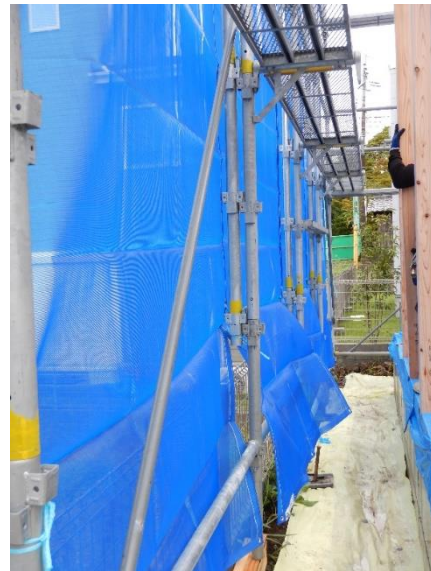
写真２－６ 一側足場（２本組み）
