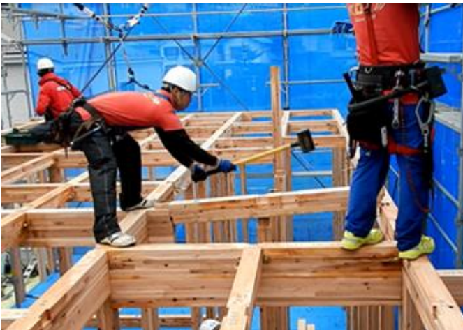
写真2-3 小梁の打込み状況
