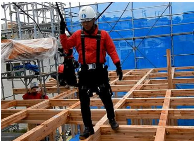
写真2-4 作業員の移動
