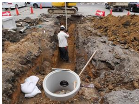
図3 下水管の埋設工事
