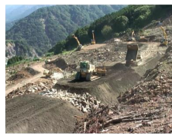
建設機械作業状況
