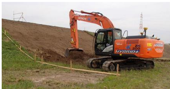
図4 法面の整形工事（写真提供：株式会社山岡組）
