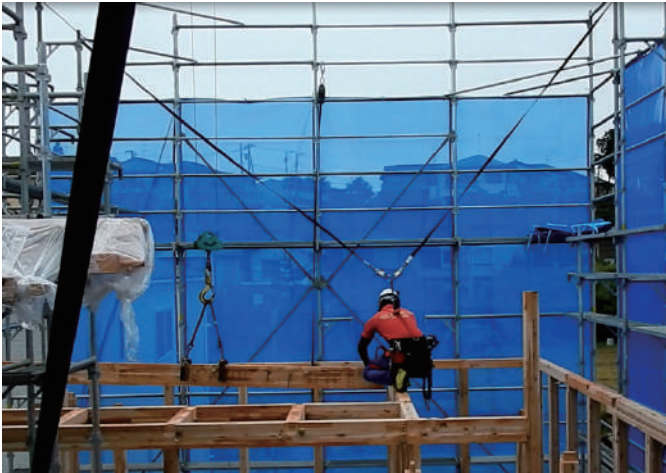
写真2-2 墜落・転落防止対策を講じた作業状況
