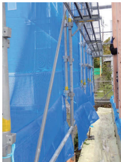
写真2-6 一側足場（2本組み）
