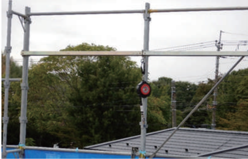
写真2-9 スライド式レール及び安全ブロックの設置状況
