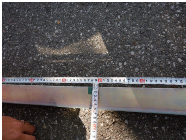
スライドレールの変形状態
