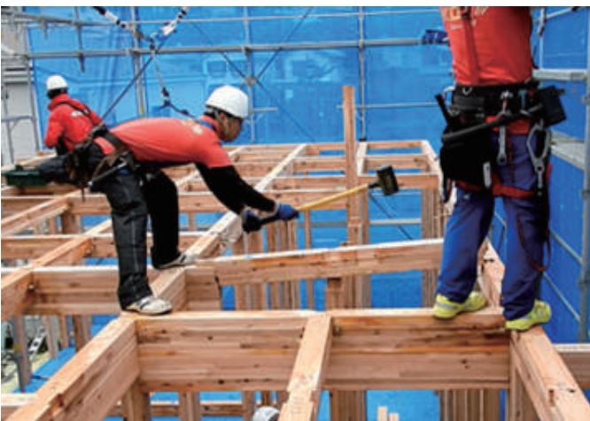
写真2-3 小梁の打込み状況
