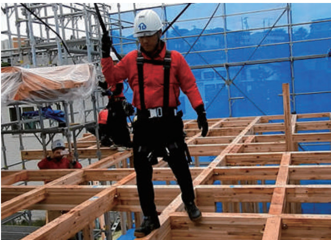
写真2-4 作業員の移動
