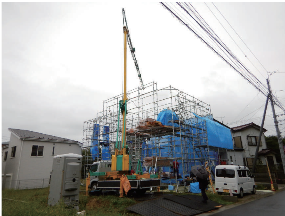
写真2-1 実態調査現場
