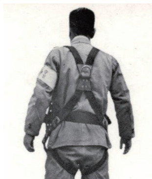
図 8－3 安全吊帯（初期のフルハーネス型安全帯）
