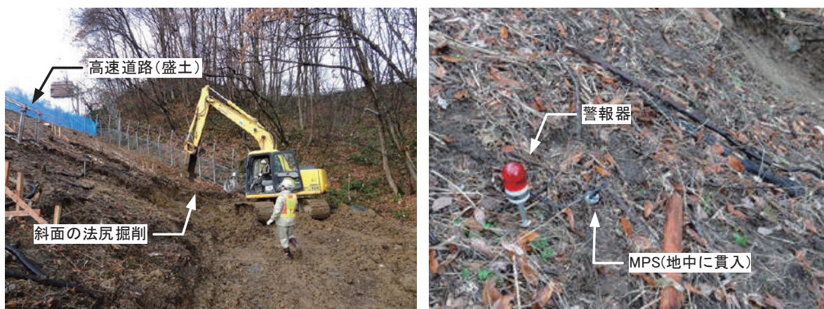
図Ⅱ-2-11 盛土斜面の法尻掘削(左)と掘削部の上方に設置した MPS 装置(右)
