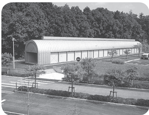
模擬トンネル
