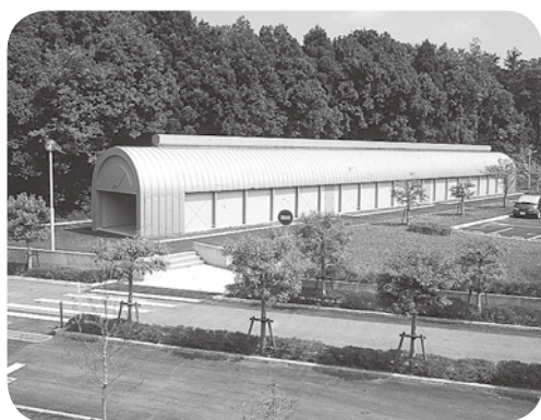
模擬トンネル
