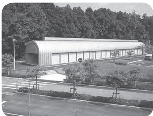
模擬トンネル
