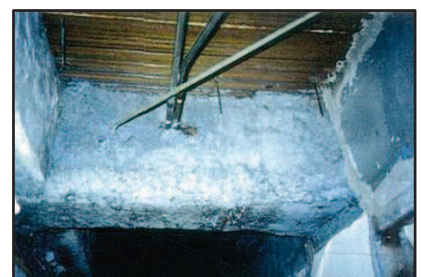
石綿による鉄骨の耐火被覆 ※12
