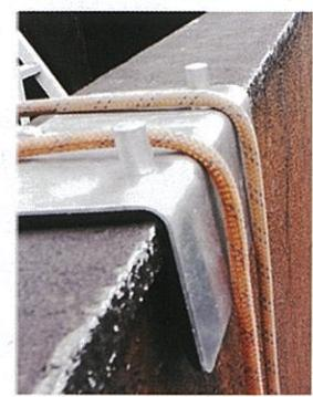
切断防止措置の例 (置き型養生) ▲
