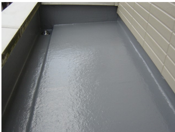
写真 1.2.1 FRP 系塗膜防水の 施工の事例
