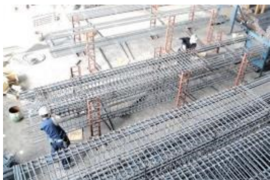
梁鉄筋工場地組
