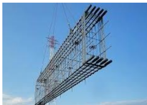
梁鉄筋地組取付
