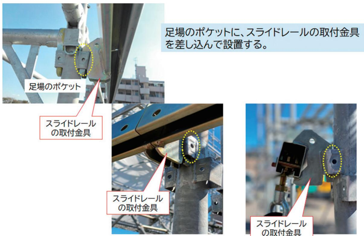
図2-28 スライドレールの取付け
