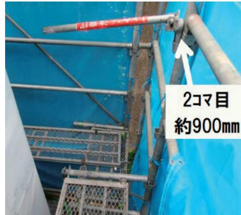
図2-18 段差のある作業床の端部にストッパーを取り付けた例
