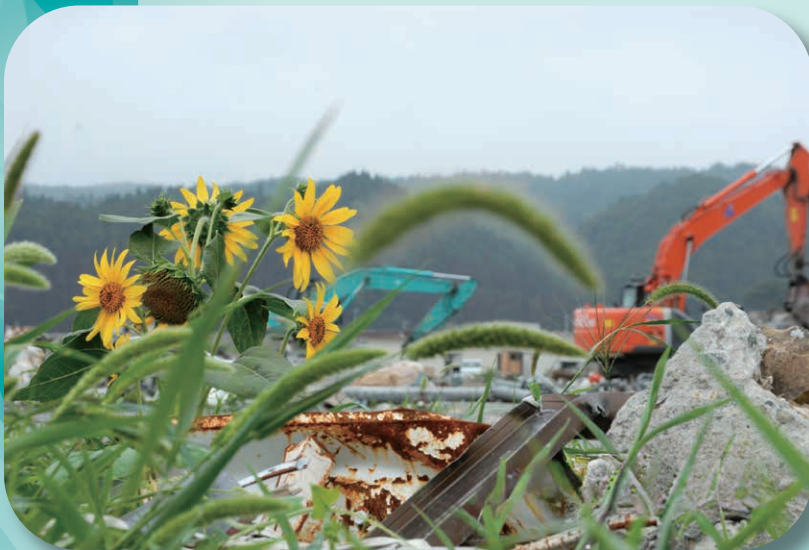
Hoa hướng dương nở trong đống đổ nát (Thị trấn Minamisanriku, tỉnh Miyagi, ngày 30 tháng 8 năm 2011)
