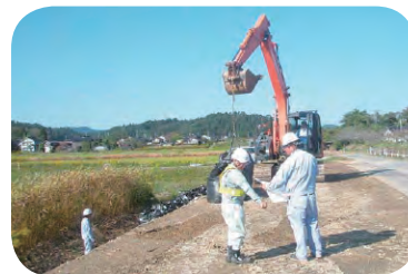
地震災害復旧工事現場
