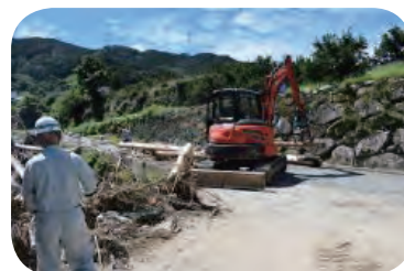
大規模地滑り災害復旧工事現場
